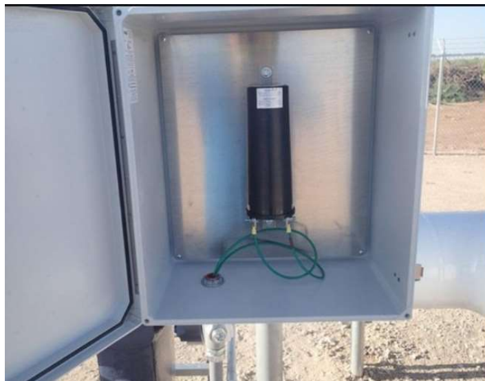
شکل (۱۵-۴۱) : استفاده از خازن به عنوان ساده ترین المان فرونشانی AC
